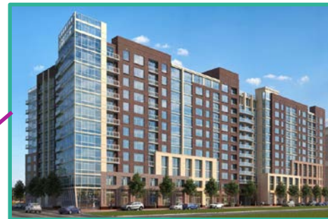
The Sur – 360 apartments
