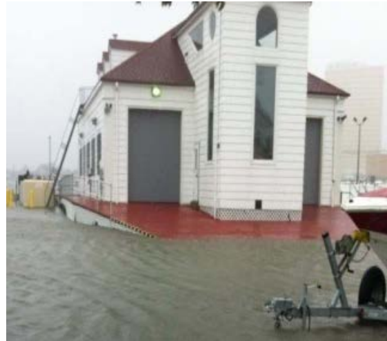
BMF STA Atlantic City
