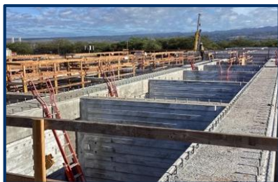
PHNS DD5 Floor Unit Fabrication
